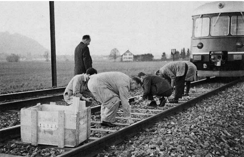
Münsingen, 9.11.1965: c’est là que les essais sur l’antidérapant de la RABDe le 12/12 1101 se sont terminés de manière affligeante. Le dispositif d’antipatinage n’était plus en mesure supporter l’adhésion artificiellement altérée et au cours de l’accostage, un moteur a grillé. L’équipe responsable des essais est justement en train de rassembler les lamelles du collecteur dispersées. (Photo: H. Schneeberger)
