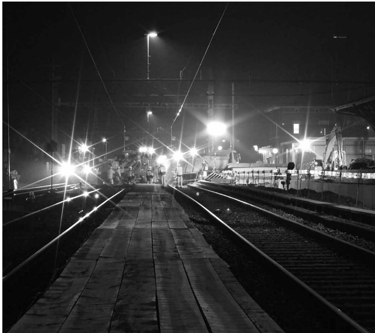
Baustelle in der Nacht
