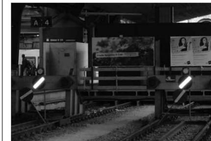
Pendant de nombreuses années, les butoirs ont été signalés de manière insuffisante et souvent leurs lampes étaient défectueuses. Actuellement, grâce entre autres au fait que des travaux sont en cours et que les voies de la halle centrale à Zurich ont été partiellement réduites, la partie terminale des voies est signalée correctement au moyen de signaux d'arrêt bien visibles ainsi que par des cibles d'arrêt, conformément au règlement des signaux.
