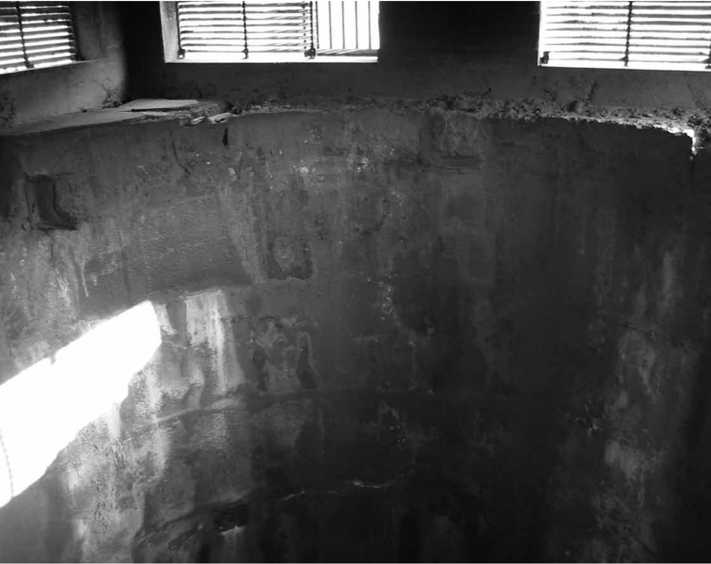
Belüftungsschacht im Innern des Bauwerks
