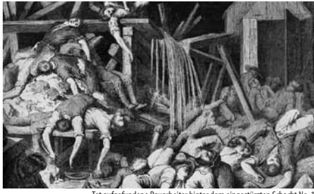
Tot aufgefundenen Bauarbeiter hinter dem eingestürzten Schacht No. 1
