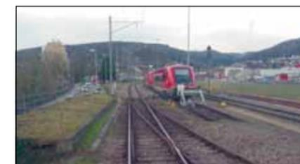
Le buttoir de Waldshut est protégé par un signal d'arrêt de protection (Sh 0 et Sh 2, avec une seule lampe rouge, 20002860 3.3.1/2).
