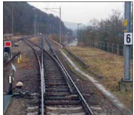
Environ 50 mètres après la fin du quai on franchit un **signal d'exécution de vitesse 60 km/h** (Lf 7 signal de vitesse 20002860 3.2.2). Ainsi nous pourrions circuler à **60 km/h**, si nous n'étions pas obligé de circuler à **40 km/h** en raison de la directive 1/2015, **40 km/h** prescrit comme vitesse de gare de Waldshut (**dernière aiguille**). Nous parcourons l'aiguille cancellée par un cadenas.
