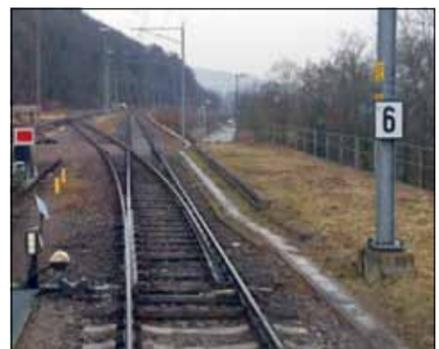
A circa 50 metri dalla fine del marciapiede (o banchina) troviamo un segnale di esecuzione di velocità a 60 km/h (Lf 7 segnale di velocità 20002860 3.2.2). Si potrebbe quindi circolare a 60 km/h se solo la disposizione 1/2015 non prescriveva 40 km/h, se solo la velocità di stazione di Coblenza non fosse di 40 km/h e se solo la velocità di stazione di Waldshut (ultimo binario) non fosse di 30 km/h. Ora superiamo un punto chiave-stellato.
