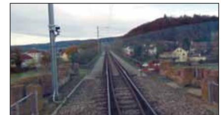
Ora attraversiamo il confine e scorgiamo il primo segnale tedesco: **esecuzione di velocità 50 km/h (Lf 7 segnale di velocità 20002860 3.2.2)**. In base al RADN, la velocità massima consentita è di **40 km/h.**
