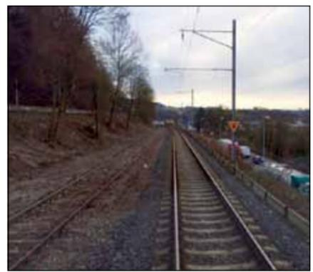
Sul binario ora troviamo un segnale di avviso 40 km/h (Lf 6 segnale di avviso di velocità 20002860 3.2.1).
