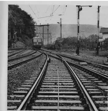
In der Gleismitte ist das Kabel der Linien-Zugbeeinflussung (LZB) gut zu erkennen. (Bei einzelnen Holzschwellen auf der Strecke sind noch heute Befestigungspunkte des LZB vorhanden.) 1975 waren sowohl Richtung Siggenthal als auch Richtung Brugg Semaphor-Signale in Betrieb.
