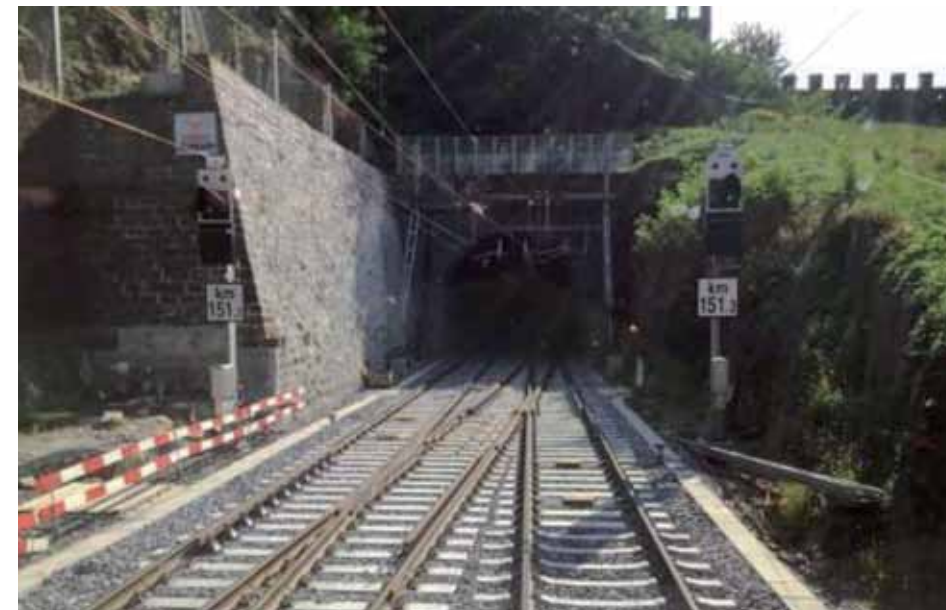
Ausfahrt Bellinzona Richtung Süden. Welches Signal für das Gleis in der Mitte gilt, ist unklar. Vermutlich keines von beiden ...? Solche Anlagen werden geplant, geprüft und es werden Fahrwege programmiert.
