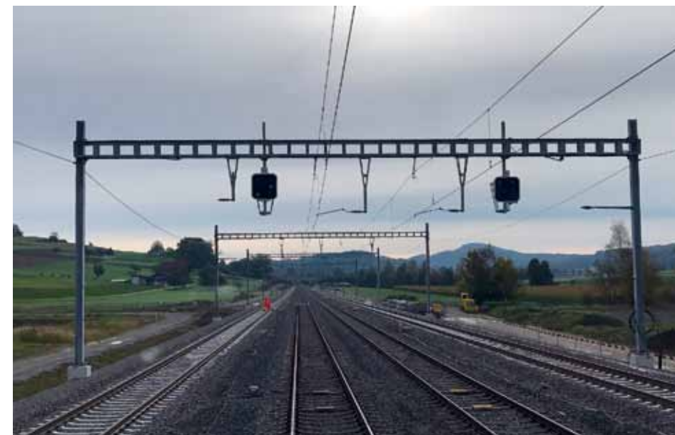
Neue Überholstation Schneit zwischen Winterthur und Wil SG (mittlerweile mit Pfeil).
