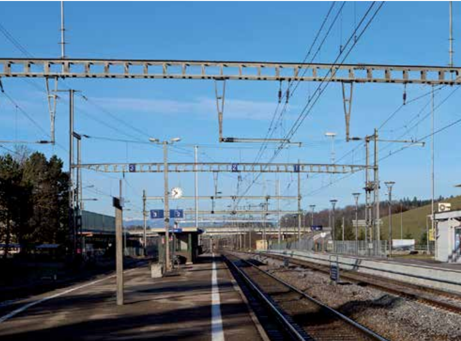
Gare de Schmitten, vue en direction de Düdingen avec la voie de rebroussement 3 sur la gauche. Photo@Olivier Tanner
