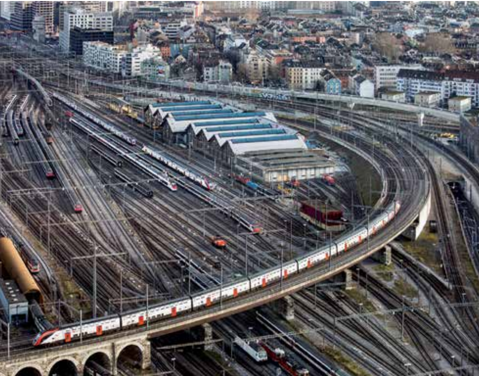
Viadukt in Zürich. Foto: Georg Trüb
