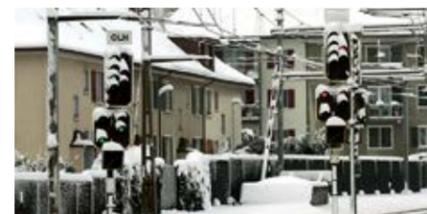
Seit einiger Zeit werden vermehrt Haupt- und Vorsignale ohne Signalheizungen aufgestellt. Betroffen bei schneebedeckten Signalen sind beim Signalsystem N (numerisch) nebst den eigentlichen Signallinsen auch die Ziffern, welche die angekündigte bzw. auszuführende Geschwindigkeit anzeigen. Auf Strecken in schneereichen Regionen, wie zum Beispiel im Jura, sind solche Einsparungen einem zuverlässigen Betrieb abträglich.
