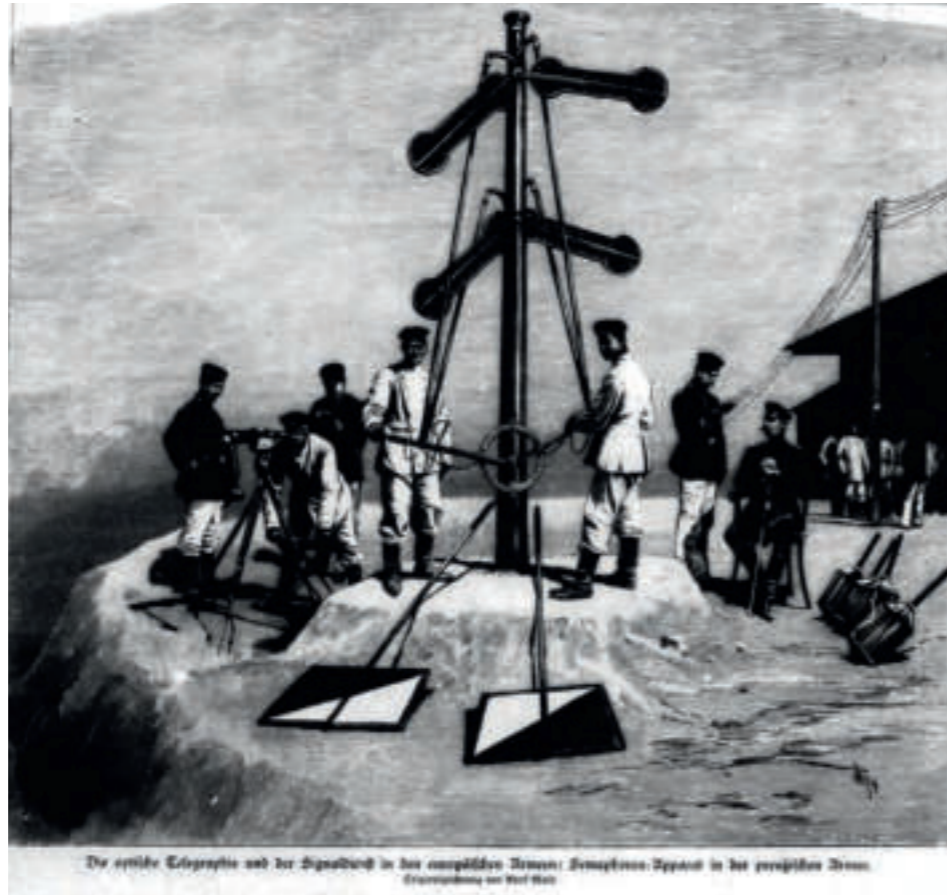
Bild 2: Apparatur für die optische Telegrafie der preussischen Armee, 1894 ( https://de.wikipedia.org/wiki/Datei:Semaphoren-Apparat_der_preussischen_Armee.jpg , 29.09.2023).
