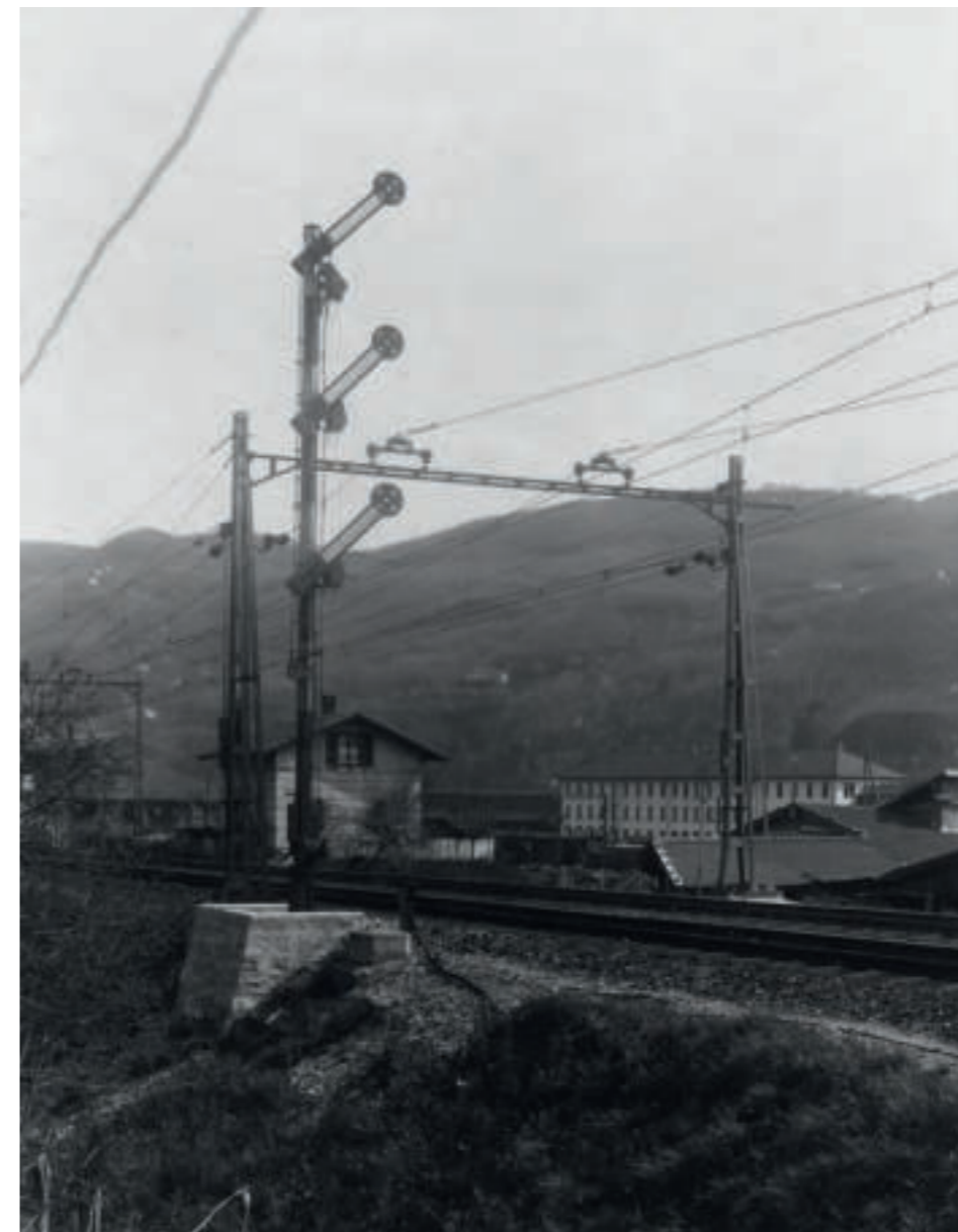
Bild 3: Dreiflügeliger Semaphor in Chiasso, 1930 ( https://de.wikipedia.org/wiki/Datei:SBB_Historic_-_F_103_00010_012_Stellwerk_Chiasso.tif , 29.09.2023)
