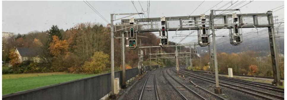
Signal d'entrée, signal avancé annonce 90 km/h à partir du tronçon d'entrée
