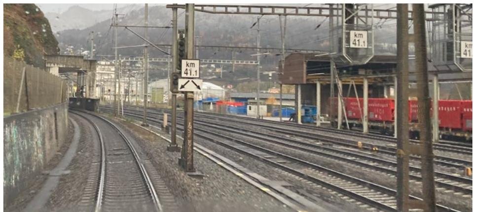
«Indicateur de modification de la vitesse maximale». À partir de là, la vitesse maximale autorisée est de 90 km/h.
