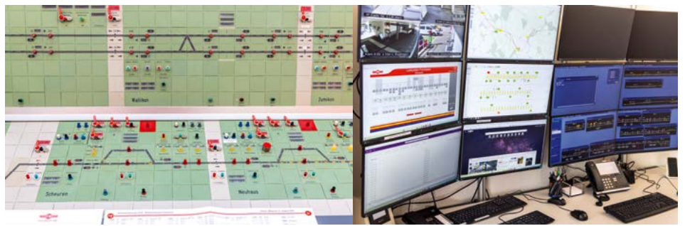
Neu vs. alt, der Domino-69-Stelltisch wird bald vollständig von ILTIS abgelöst.
