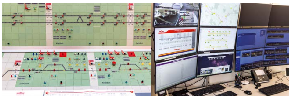
Nuovo vs. vecchio, il banco di manovra Domino-69 sarà presto completamente sostituito da ILTIS
