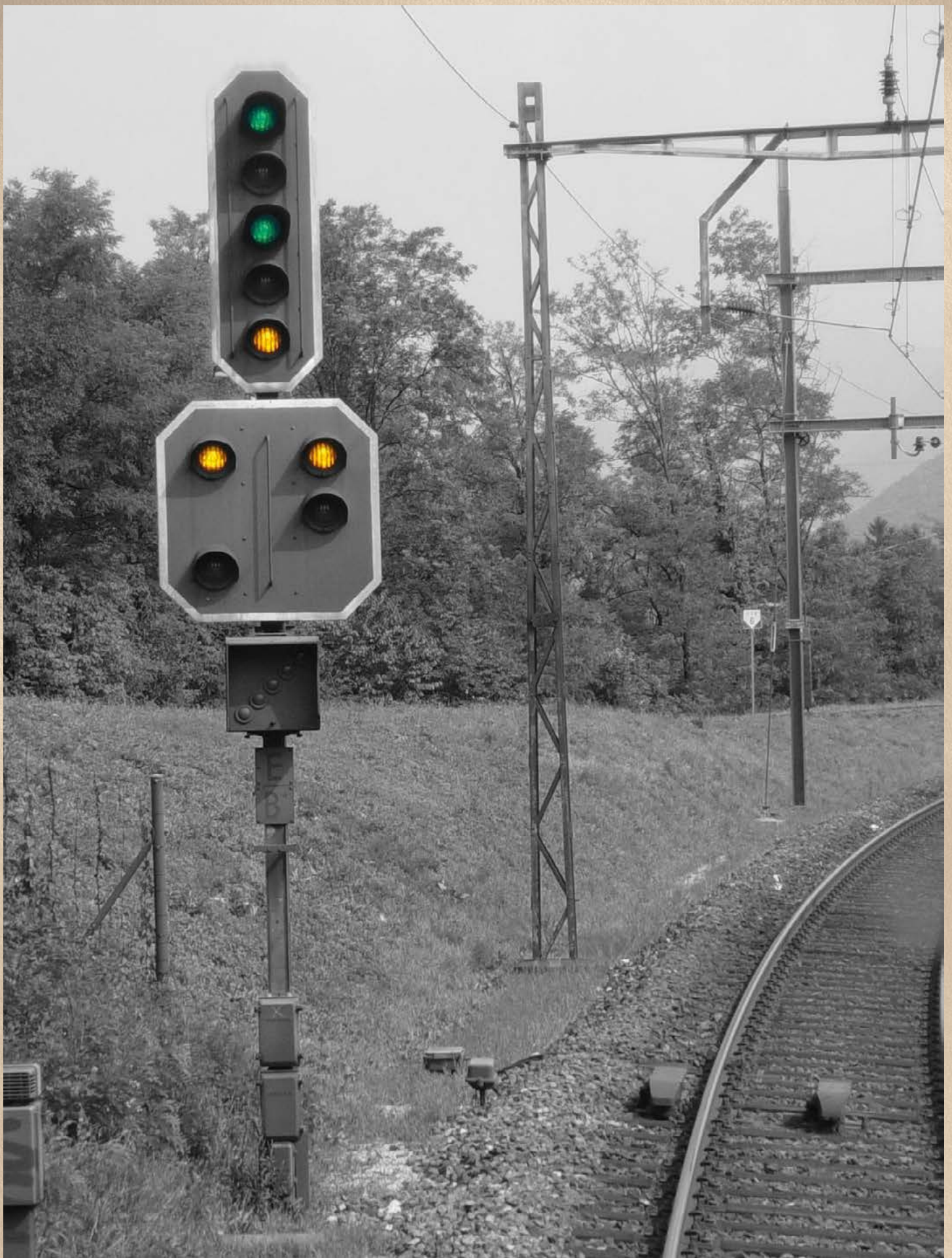
Einfahrtsignal von Mendrisio aus Richtung Balerna. Als es 1962 in Betrieb genommen wurde, konnte es tatsächlich den Fahrbegriff 4 zeigen. Mit den Änderungen des Reglements 1967 wurde diese Möglichkeit aufgehoben. Dieses Signal wurde 2012 beim Umbau der Sicherungsanlage durch Signale vom Typ N ersetzt.
