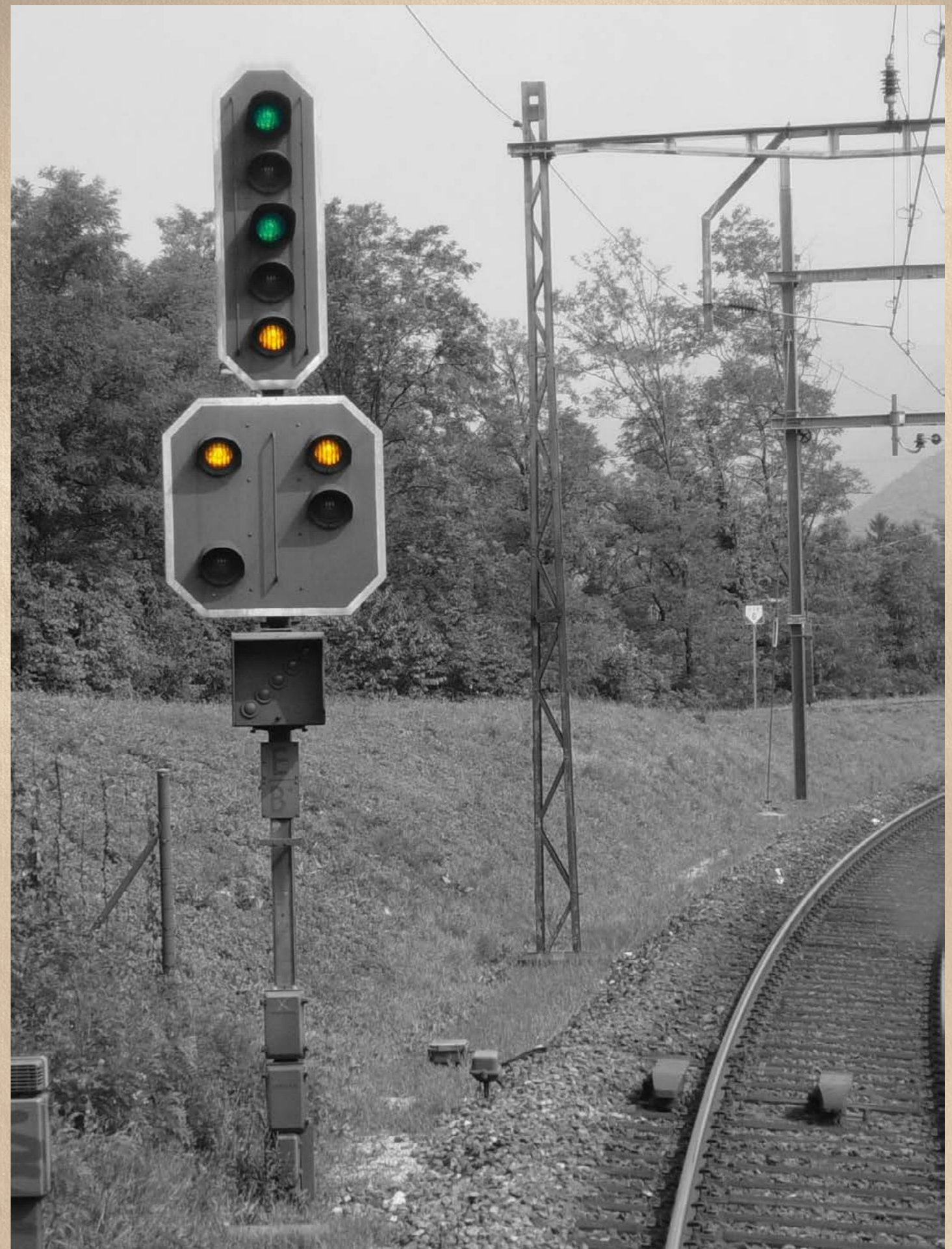
Signal d'entrée de Mendrisio en provenance de Balerna. Lorsqu'il a été mis en service en 1962, il pouvait effectivement afficher l'image 4. Avec les modifications du règlement de 1967, cette possibilité a été supprimée. Ce signal a été remplacé en 2012 par des signaux de type N lors de la rénovation de l'installation de sécurité.
