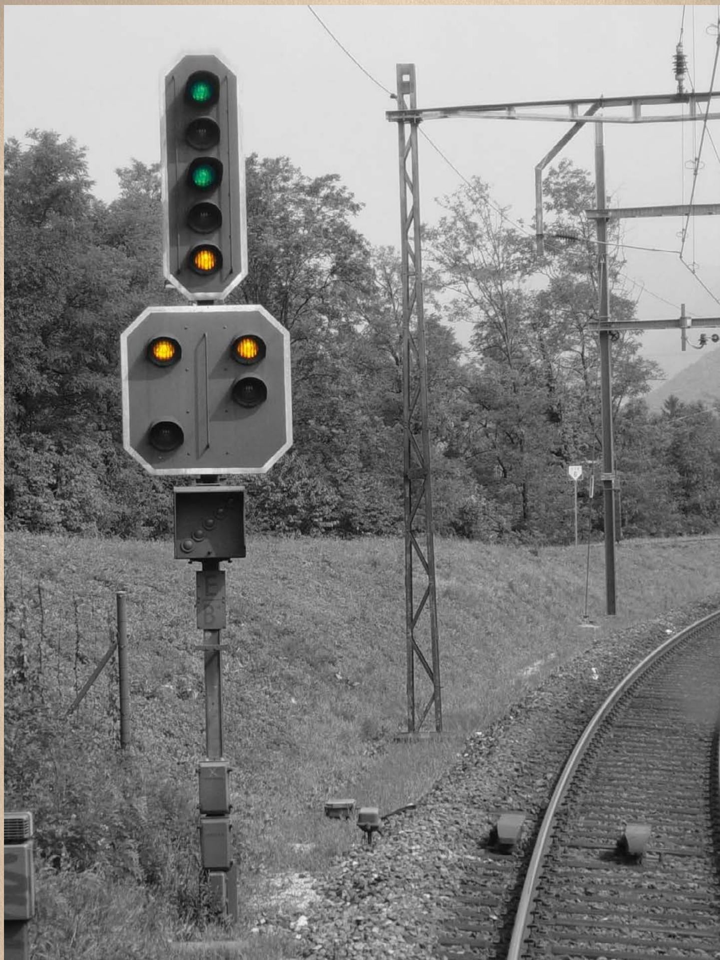
Segnale d'entrata di Mendrisio proveniente da Balerna. Al momento della sua messa in servizio, nel 1962, poteva effettivamente presentare l'immagine 4. In seguito alle modifiche introdotte al regolamento nel 1967, questa possibilità fu soppressa. Questo segnale è stato sostituito nel 2012 con segnali tipo N in occasione del rifacimento dell'impianto di sicurezza.
