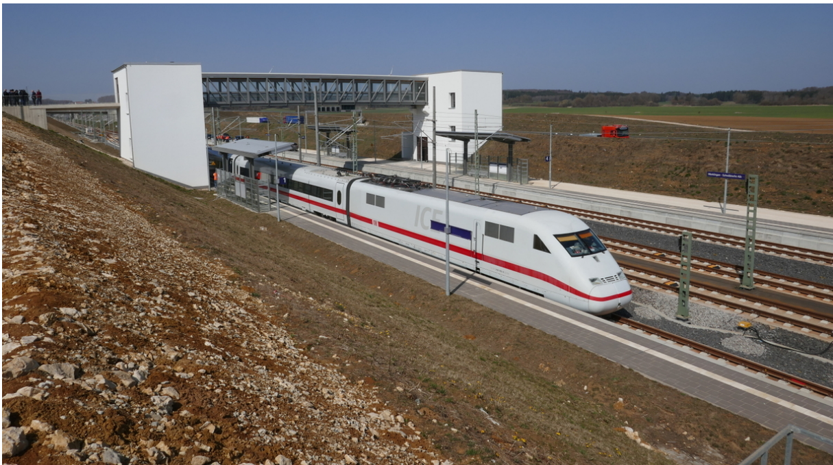
Auf der Neubaustrecke Wendlingen-Ulm setzt die Deutsche Bahn auf das Sicherheitssystem „ETCS“. © Foto: Joachim Striebel.
