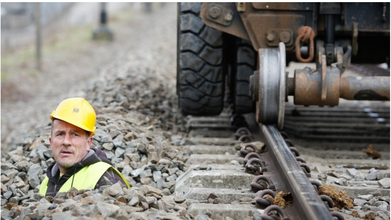
Kontrollarbeiten bei einer ETCS-Aufrüstung in Belgien
